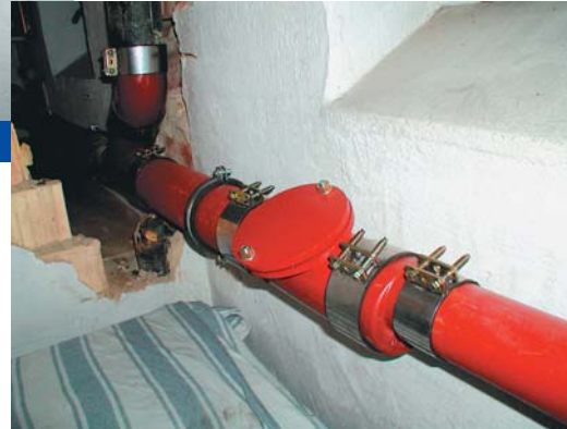
Installation von Abwasserrohren auf Kellerwänden
