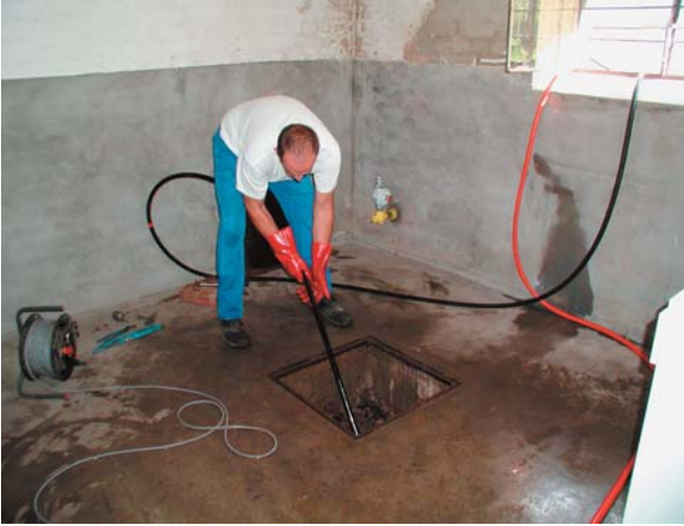
Reinigung der Grundleitungen
