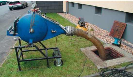
Einbau eines Inliners
