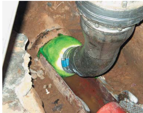
Einbau eines Inliners
